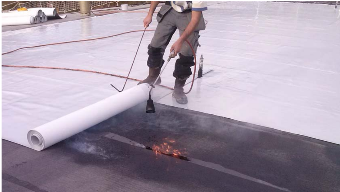
Figure 14 – Mise en œuvre de la membrane EVALON® V par réchauffage à la flamme du bitume
