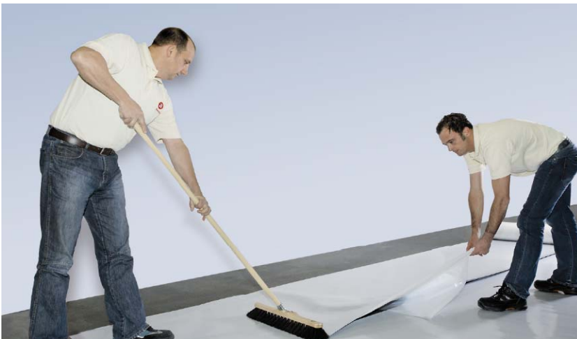
Figure 15c – Lissage de la membrane et marouflage
