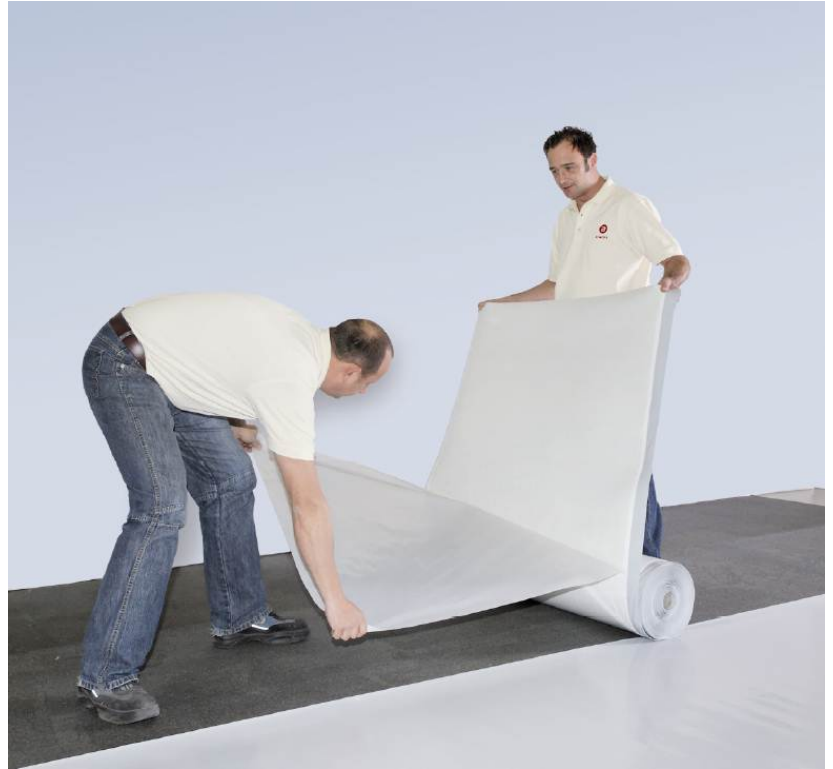
Figure 15b – Dépose du film de protection de la couche autoadhésive
