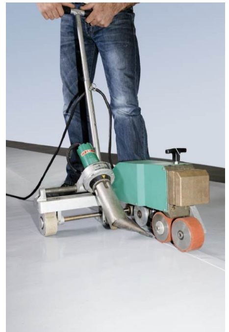
Figure 15d – Soudure à air chaud de la membrane
