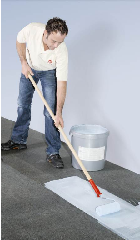
Figure 15a – Application du primaire alwitra Haftgrund SK-L
